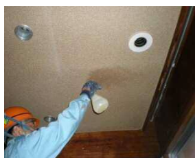
（飛散抑制剤にて湿潤化）
