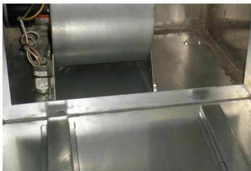
写真Ⅶ-5 コーキング処理
