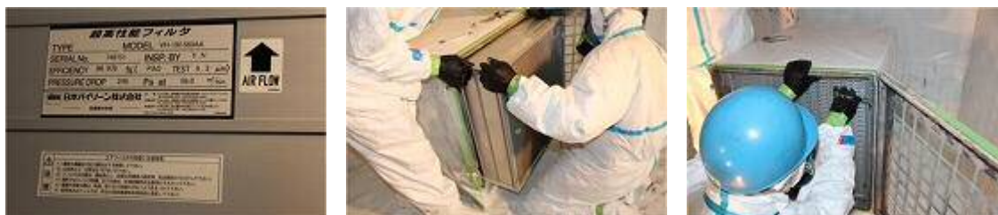
写真VI-11 フィルタの取り付け
