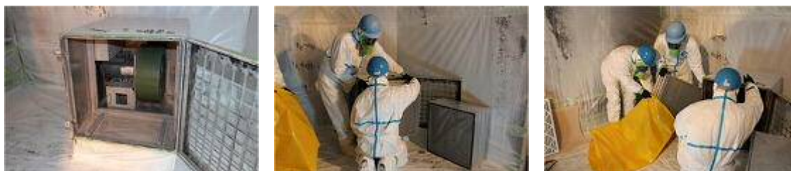
写真VI-10 HEPAフィルタの交換
