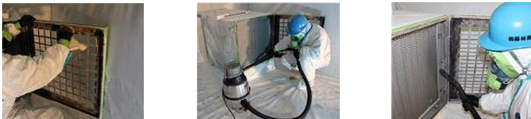
写真VI-8 HEPAフィルタ等の清掃
