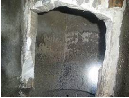
写真Ⅱ-9 ハイスタック煙突断熱材
