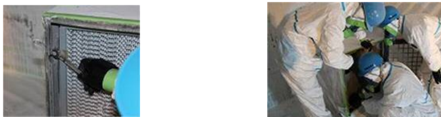
写真VI-9 HEPAフィルタの留め付けの緩み点検
