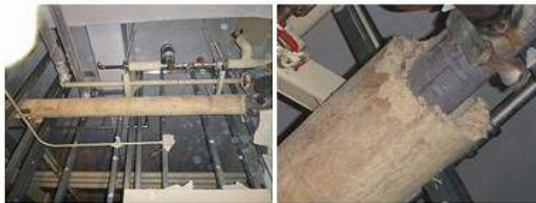
写真Ⅱ-14 直管部分にも使われる配管保温材
