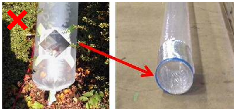
図-15 ビニールダクトの先端部分を環状の支え（アルミ製ダクト）を重ねて使用した例
