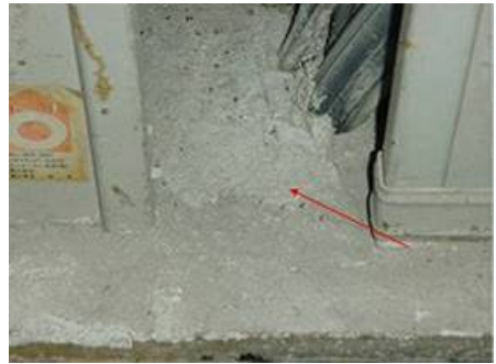
写真Ⅱ-12 電気配線部分隙間閉鎖
