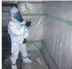
写真VI-2 養生シートへの散布
