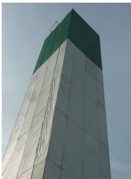
写真-1 垂直ネットによる煙突頂部養生例
