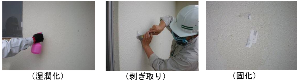
図－４ サンプルング例（外壁材）
