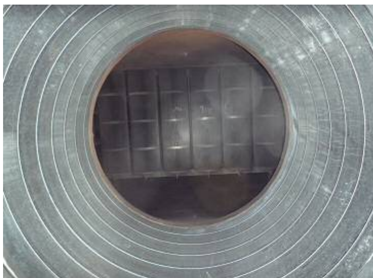
写真区－5 吸込ダクト内部（φ1,300）の例
