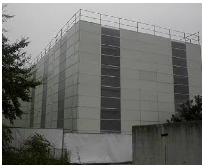
写真-2 防音パネル／採光防音パネル施工例
