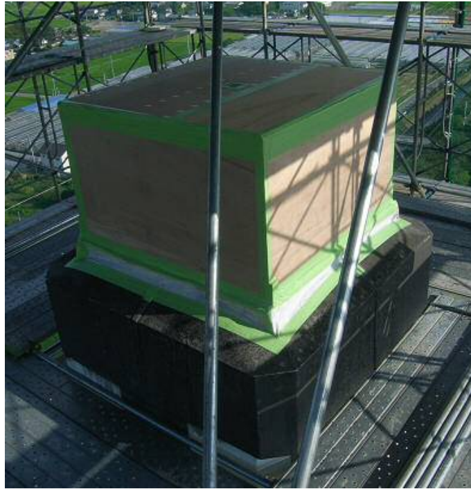
写真－3 煙突開口部養生例
