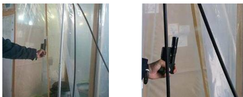
図-29 セキュリティーゾーンの入口の気流方向の確認
