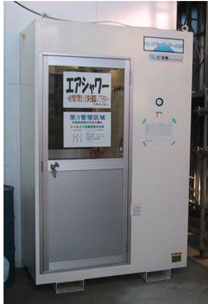
写真区-4 エアシャワールーム（2重扉）の例
