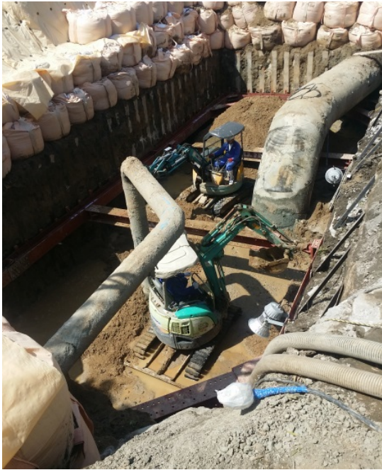
写真 5.2.6 \phi 1350 鋼管(溶接) 人孔管フランジ部の漏水 (東区画図町下無田, 配水 No. 176)
