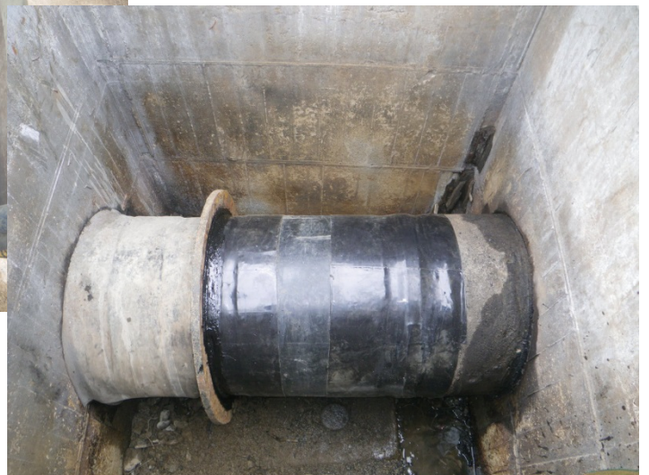
写真 5.2.15 \phi 700 仕切弁破損部の補修状況（東区秋津町沼山津, 同上）
