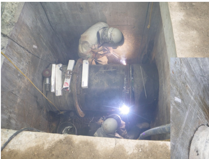
写真 5.2.14 \phi 700 鑄鉄製仕切弁の破損（東区秋津町沼山津, 付属 No. 85）
