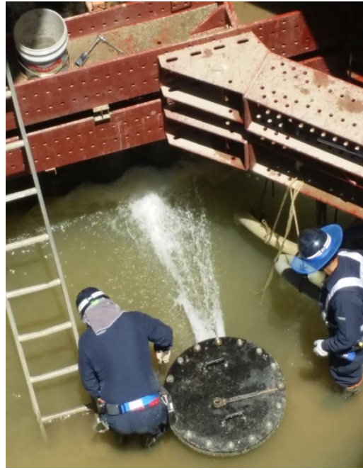
写真 5.2.6 \phi 1350 鋼管(溶接) 人孔管フランジ部の漏水 (東区画図町下無田, 配水 No. 176)
