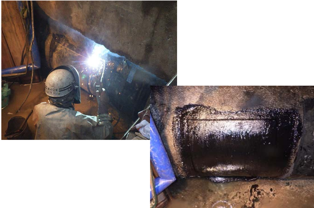
写真 5.2.3 φ800 鋼管（溶接）の作業孔準備復旧（東区上沼山津橋右岸）
