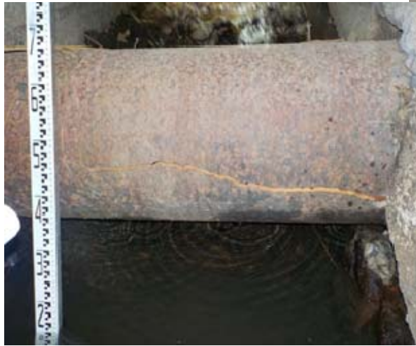
写真 5.2.8 \phi 350 鑄鉄管 管体被害 (西区上熊本 3 丁目, No. 33)
