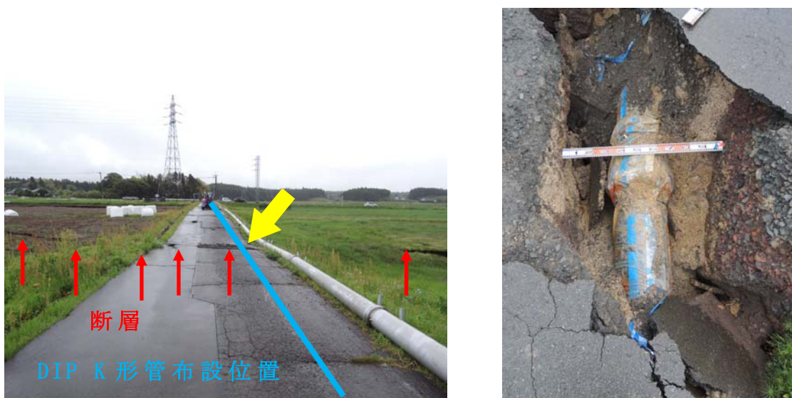
写真 5.4.2 及び写真 5.4.3 断層横断部に埋設されていた DIP K 形 φ 300 (漏水の有無は確認できず、阿蘇市赤水 1346 付近)
