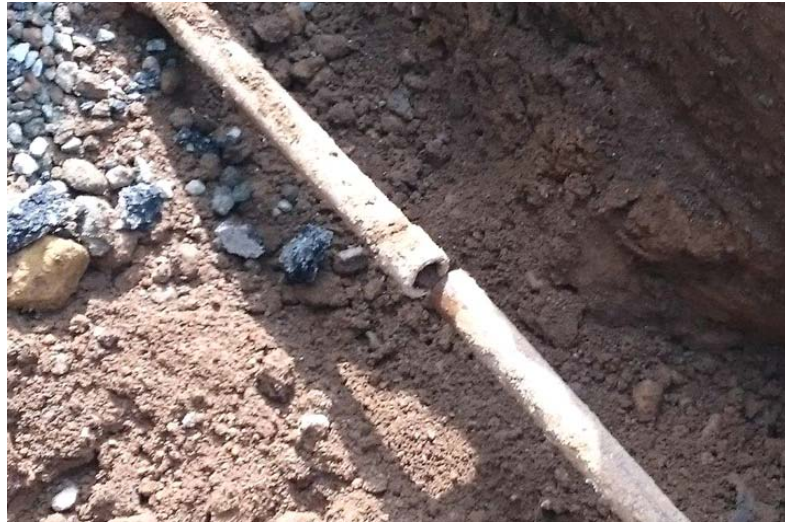
写真 5. 6. 3 SP ねじ継手 φ40 被害状況
