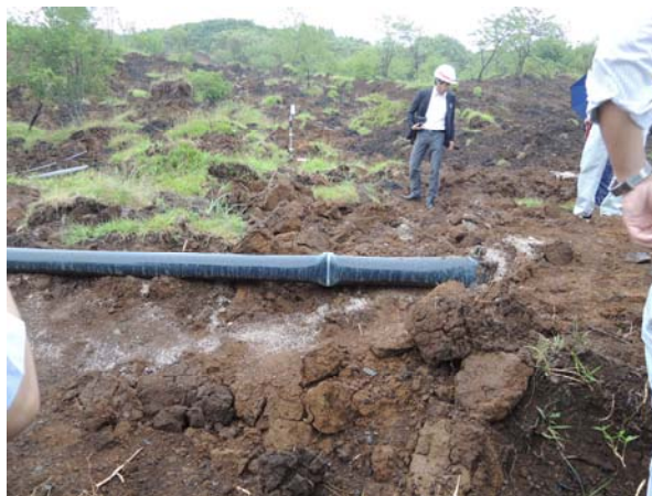
写真 5.5.1 及び写真 5.5.2 VPφ125 被害 (南阿蘇村河陽県道 149 付近)
