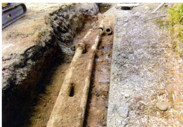
写真 5.3.1 断層横断部の DIP K 形 \phi 200, \phi 150 2 条配管抜け (益城町平田 961 付近)
