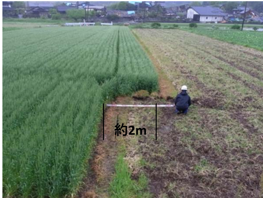
写真 5.3.3 約 2m の断層変位（益城町上陣 531 付近）
