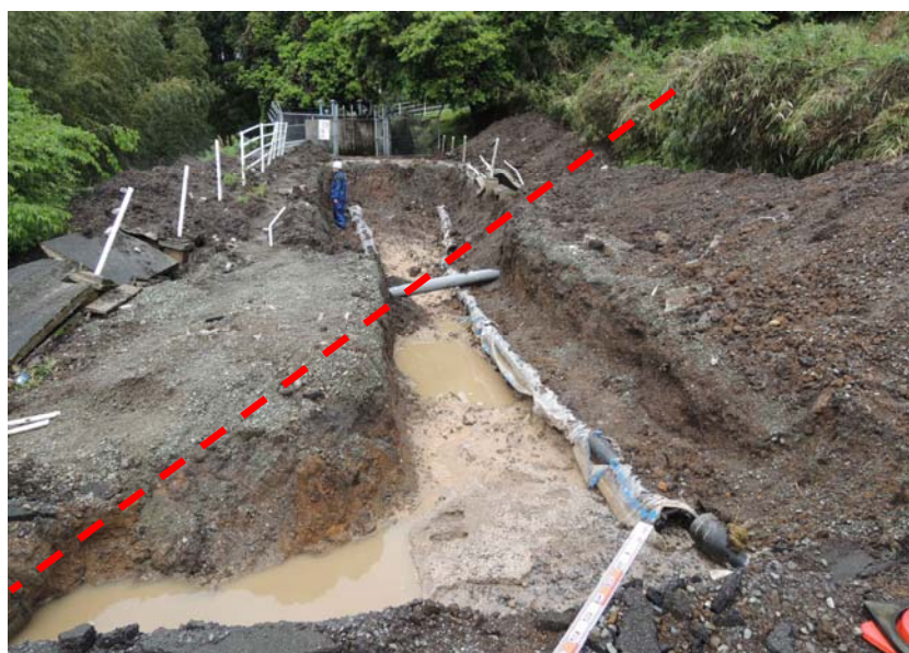
写真 5.6.1 断層部における DIP A 形 \phi 200 , \phi 250 2 条配管抜け被害 (西原村小森 932 付近)
