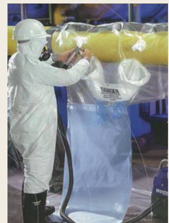
グローブバッグ工法による作業範囲が部分的な工事
