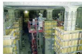
配水池の耐震化工事 30 (内面からの壁・柱等の補強)
