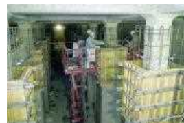
配水池の耐震化工事(内面からの壁・柱等の補強)
