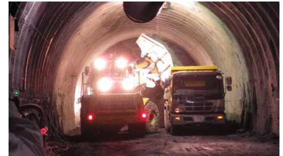
車両系機械によるずり出し作業
