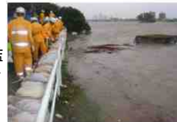
越水に対応するための積土の土工
