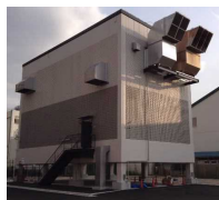
非常用自家発電設備のイメージ
