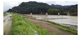
送水管を添架していた沖鶴橋の流出 (熊本県球磨村)
