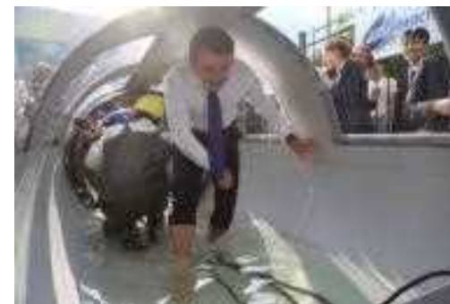
▲下水道管路更生
