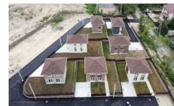
▲完成した7戸の木造住宅
