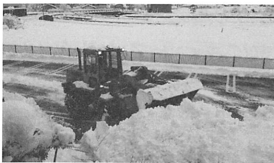
写真 地元建設業者は積雪期には、新潟市出勤基準にかかわらず出勤してもらい、患者のスムーズな来院に貢献している。
