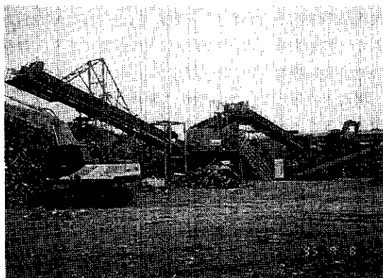
写真1 仮置場におけるがれきの破砕・選別設備 (西宮市, 9/8現在)
