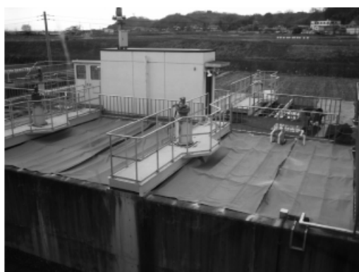
【高崎市 岩崎浄水場 ろ過地 覆蓋】
