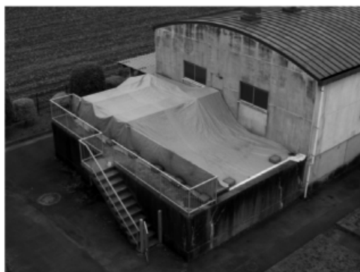
【筑西市 成田浄水場 着水井 覆蓋】
