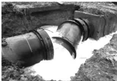
写真2 東日本大震災による水道管の被害 [1]
