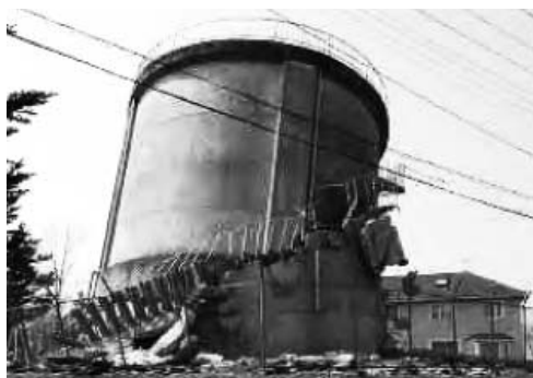
写真1 東日本大震災による配水池の倒壊 [1]
