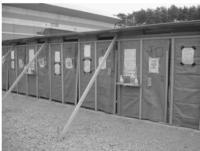
写真2 避難所に設置された仮設のトイレ
