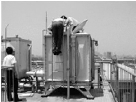
図1 貯水槽の検査風景
