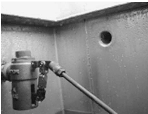
図4 逆流防止構造が不良な設備
