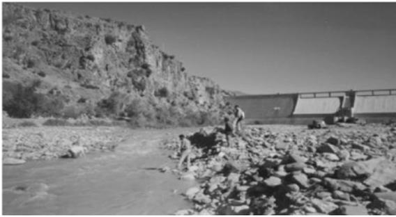
図10 同位体技術を用いたダム漏水検査（コスタリカ） 上流域のダム貯留水にマーカとなる同位体を投与し、ダムの下流域で採水、分析、そしてダムからの漏水率を評価する。
