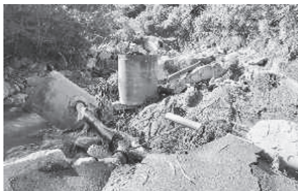
図 2 2019年東日本台風による水道の被災状況（上：浄水場の冠水, 下：浄水場の取水口流出） 文献[16]を転載
