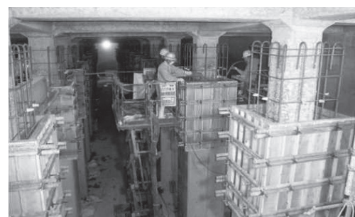
図3 水道施設の緊急点検を踏まえた災害対策の例（上：浸水災害対策のイメージ、下：配水池の耐震化工事）文献[33]より転載
