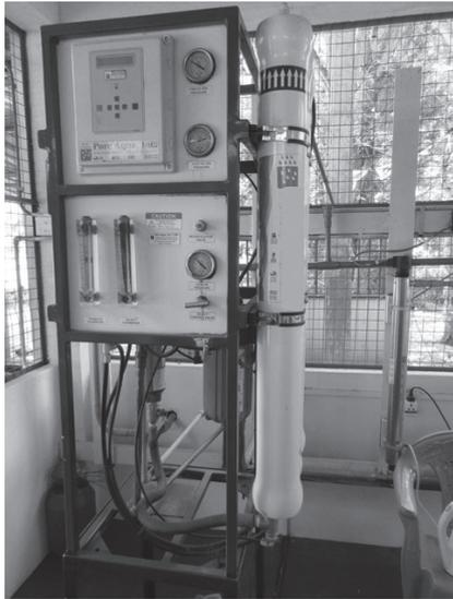
図6 小規模水供給施設に備えられたRO膜ろ過ユニット
