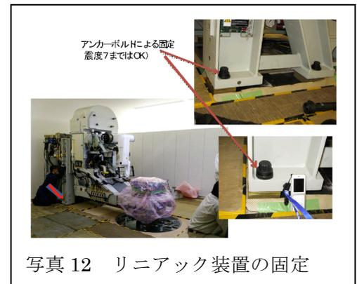
写真12 リニアック装置の固定
