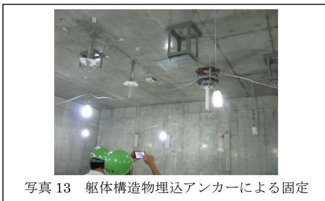
写真13 躯体構造物埋込アンカーによる固定
