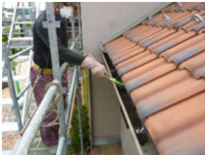
図3 局所除染の例（雨樋の除染）
