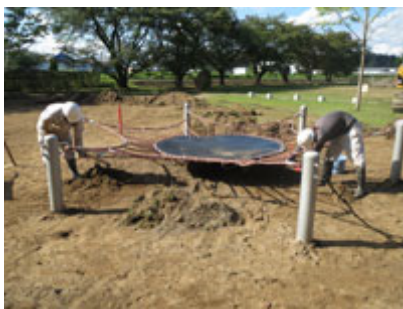
図2 面的除染の例（公園の除染）
