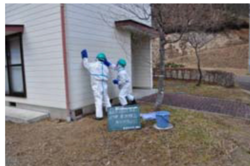
図7 住宅壁面の除染の例 [11]
