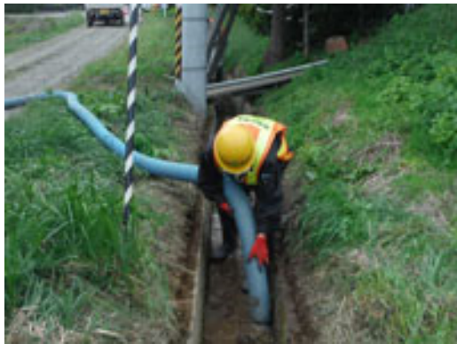
図6 側溝の除染の例
