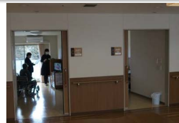
ユニット型の居室扉の状況
