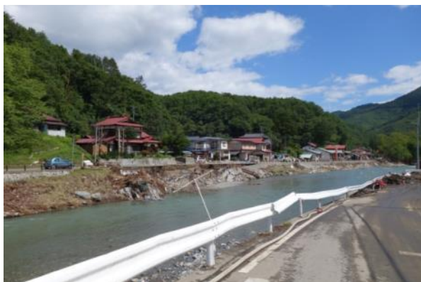
岩泉町安家地区の被害の様子 1
