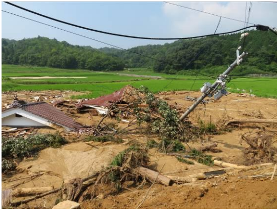
土砂で潰された住宅
