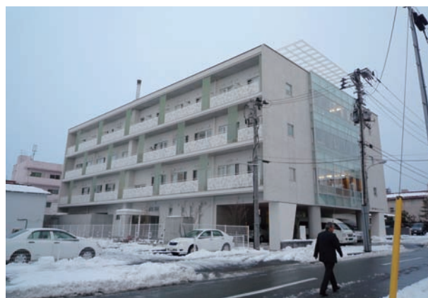
④ 新設した総合ケアセンター外観
