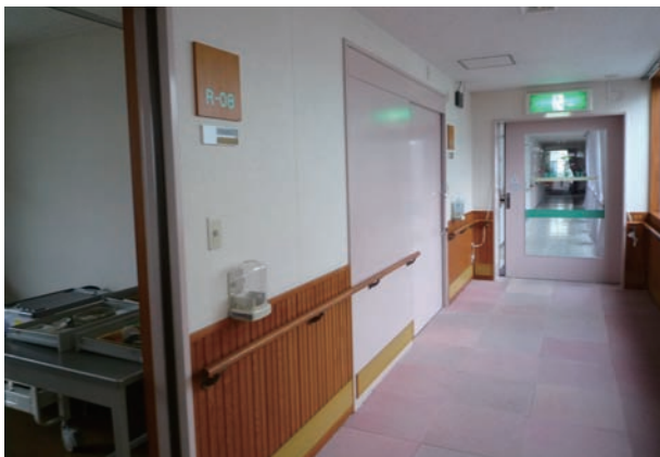
① 病室部分は現在は使用していない
