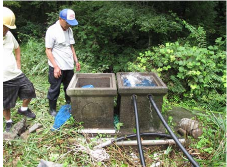
浄水処理施設 炭＋砂＋砂利
