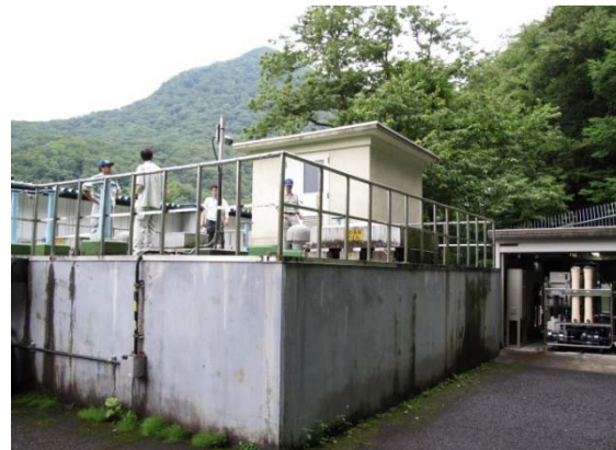
n旧簡水の浄水施設
