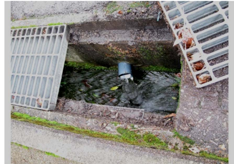
排泥作業の様子
