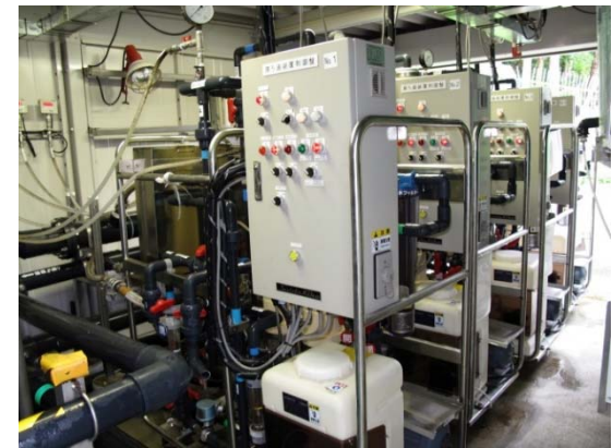
t旧簡水の浄水施設
