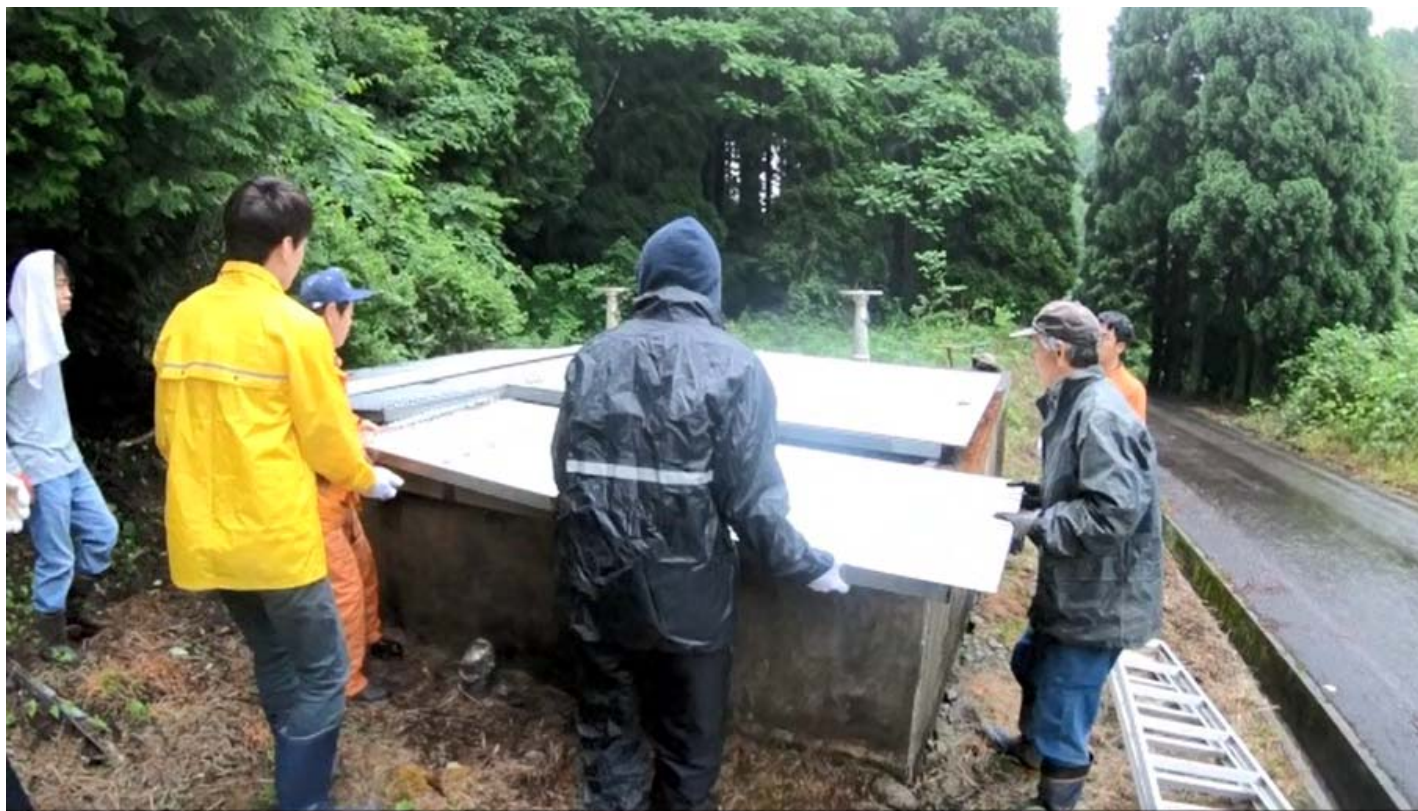
ろ過池の清掃作業
