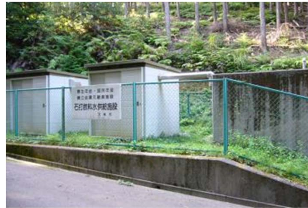
浄水(急速ろ過) 配水池(RC製)
