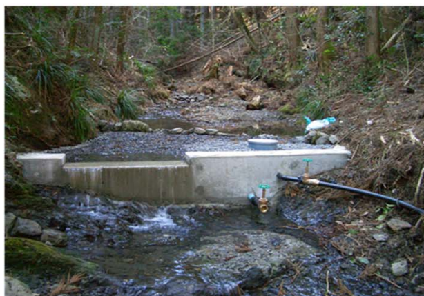
取水施設を整備し、浄水場へ送水
