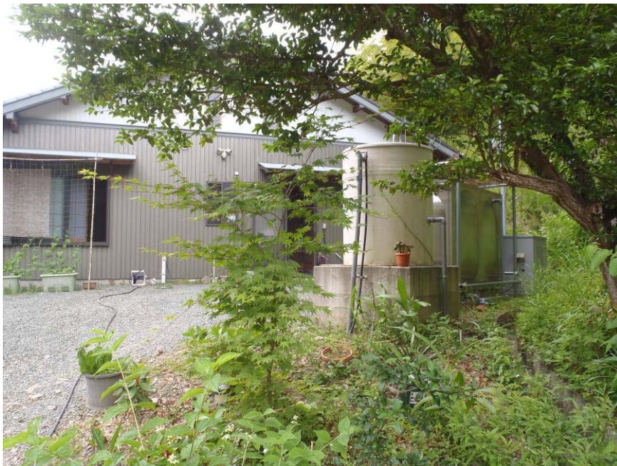
庭先に設置された施設
