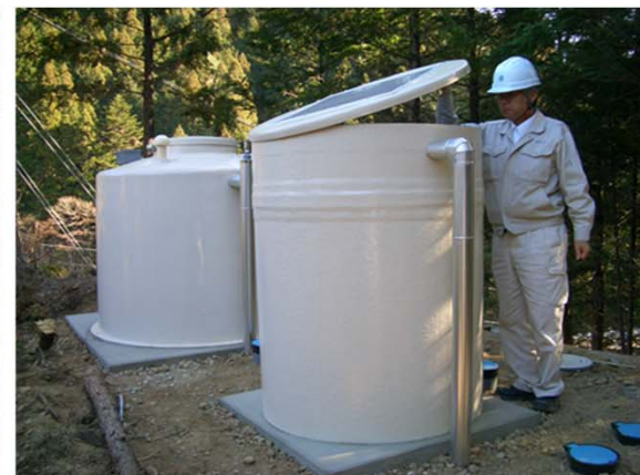
簡易ろ過池(手前)でろ過した水を 配水タンク(後方)へ貯水
