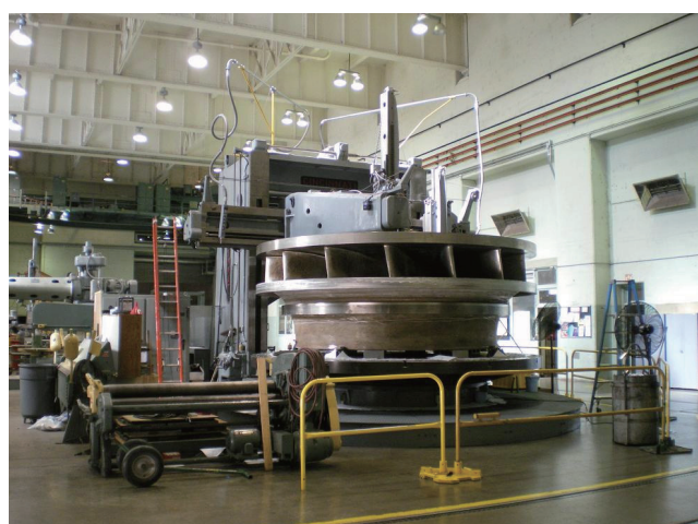
写真12 水力発電タービン分解修理の様子
