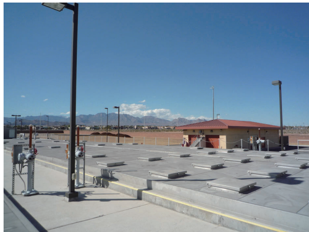
写真 32 同センター沈殿池
