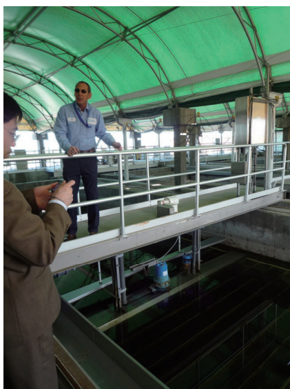
写真 33 同センター処理水槽
