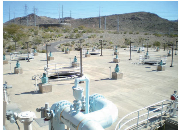
写真 22 同浄水場ろ過池
