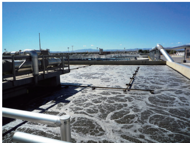
写真 28 同処理場反応槽
