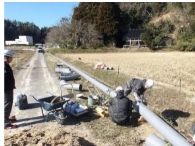
区域の下水を集約し処理場にする圧送管の被災（珠洲市熊谷ポンプ場からの圧送管）
