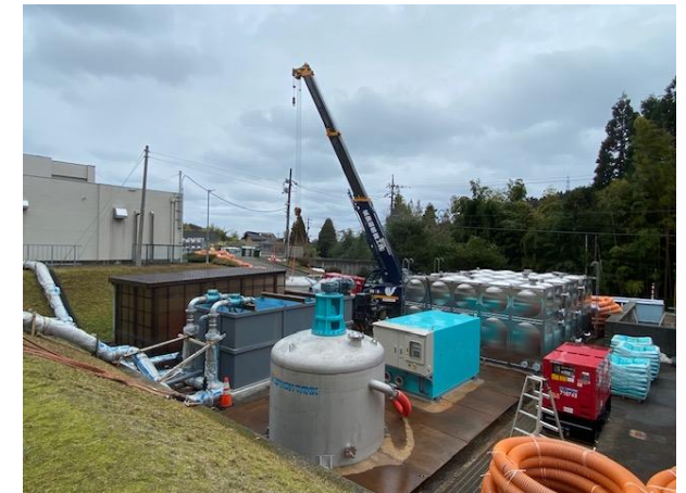
宝立浄水場可搬式浄水施設・設備 (名古屋市上下水道局)
