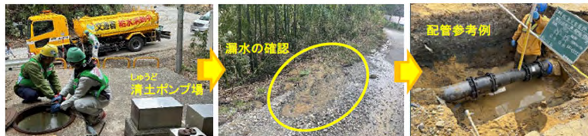
輪島市清土ポンプ場 日本水道協会による配水管漏水調査への給水支援 (輪島市門前地区 横浜市と連携した漏水調査、管路洗浄のための給水)
