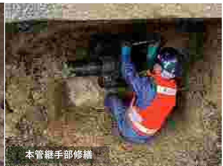
フクロジョイントによる補修
