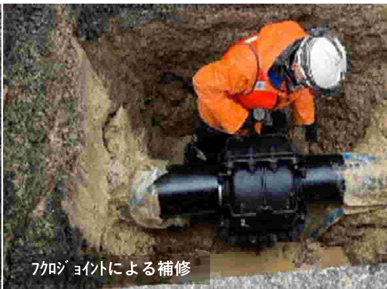
フクロジョイントによる補修
