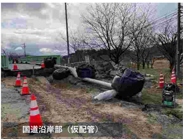
管取替による補修（導水管）
